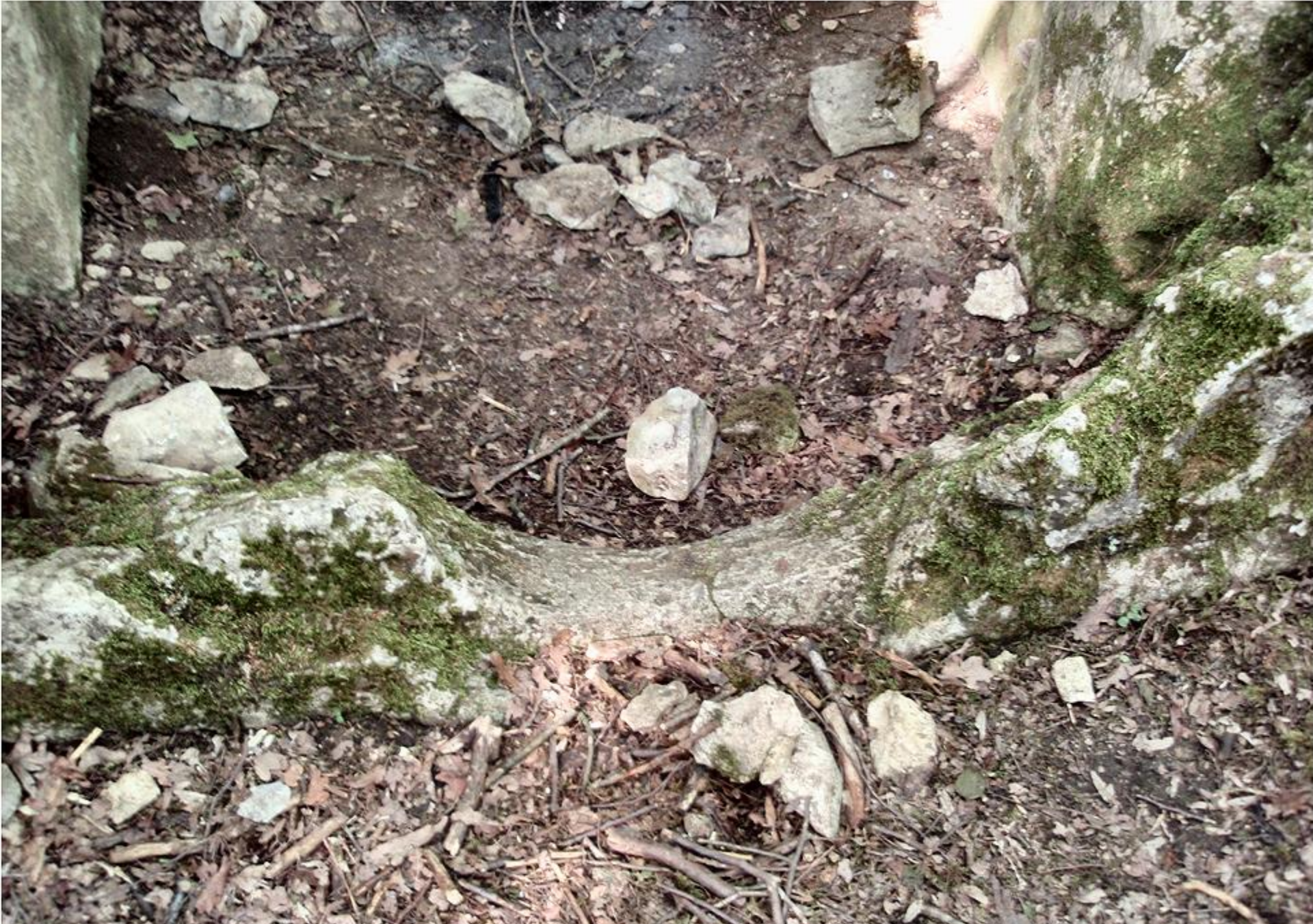
Bas de l'ouverture de la cloison séparant le vestibule de la chambre funéraire
