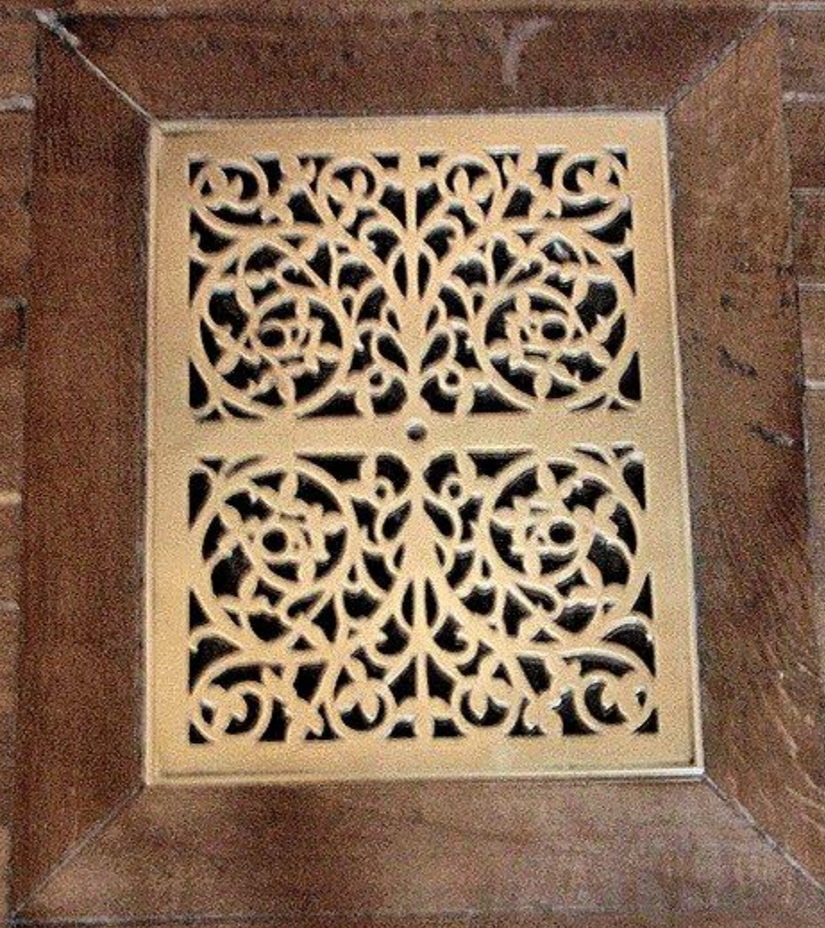
Une bouche de chauffage dans le parquet
